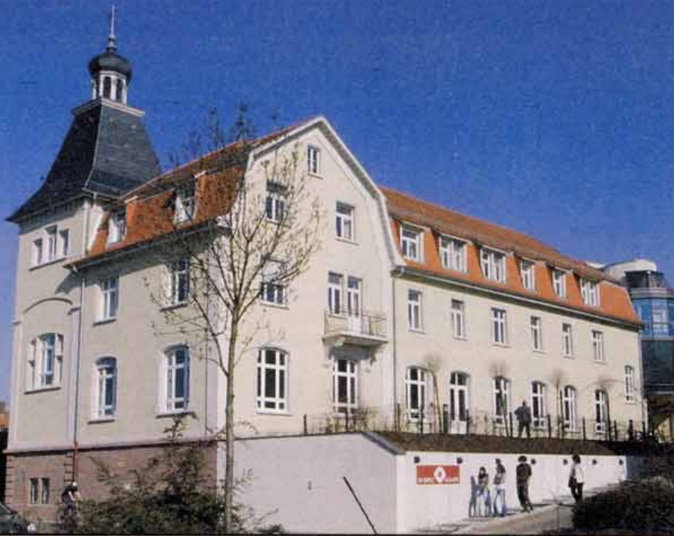
Das renovierte Gebäude von der Heidelberger Straße aus gesehen.
